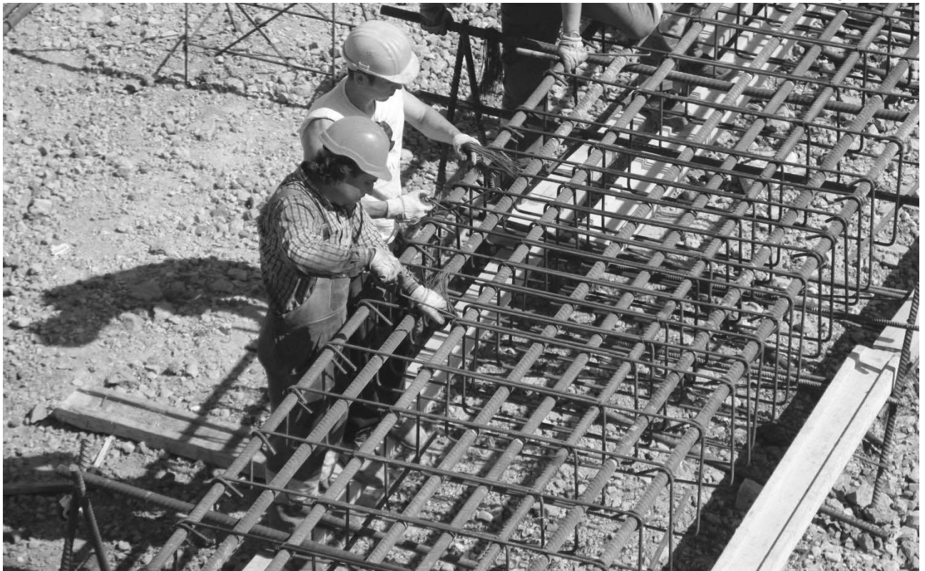
Рис.3. Использование подмостей для рабочих при вязке арматурного каркаса
