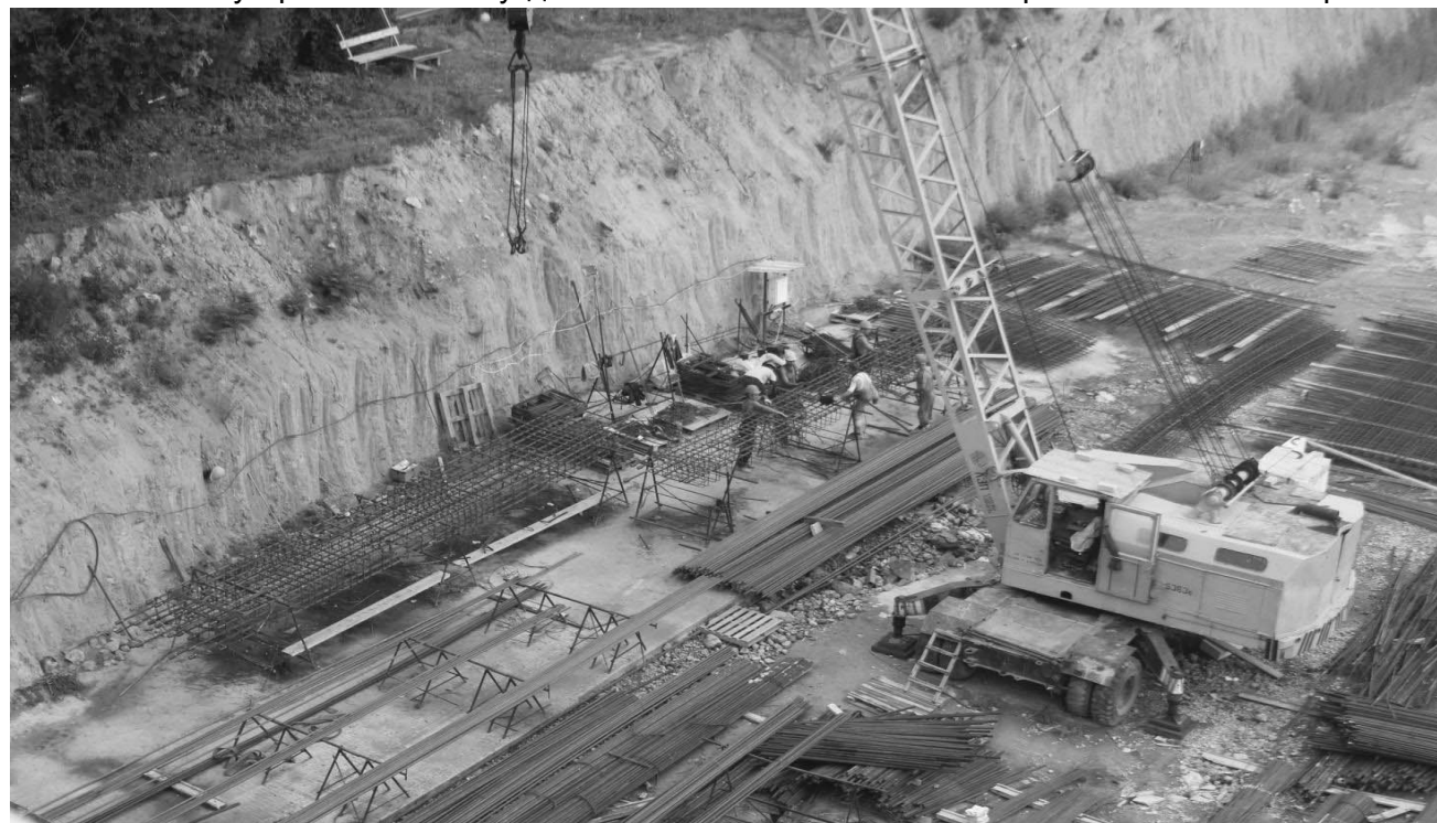
Рис.5. Общий вид арматурной площадки по изготовлению каркасов
